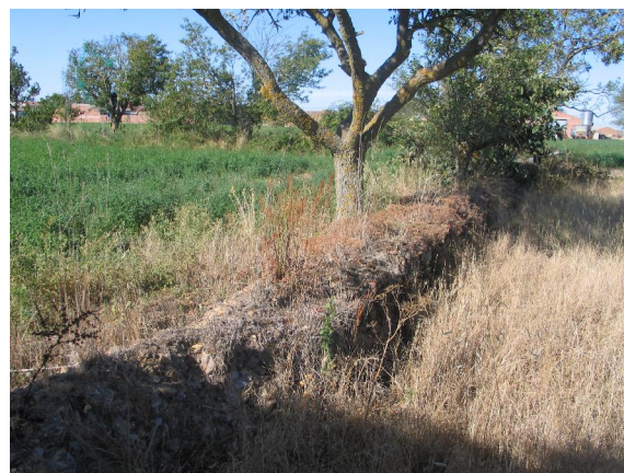
Ídem. Detalle del muro este de la estructura.
