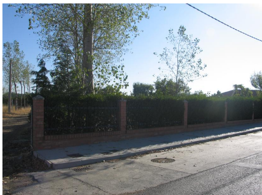
Extremo nororiental. Parcela 54 la cual se encuentra parcialmente construida.
